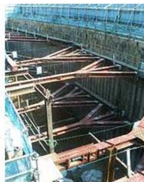
Địa điểm đo tường chắn
