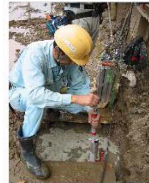
Lắp thiết bị đo độ nghiêng nhiều lớp
